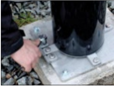
Verschraubte Fußplatte, Säule durch Klappmechanik abklappbar Screwed base plate, column can be folded down using the folding mechanism Plaque de base vissée, la colonne peut être rabattue à l'aide du mécanisme de pliage
